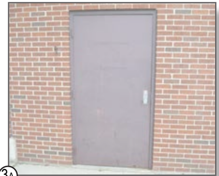
③A HOLLOW METAL DOOR & HOLLOW METAL FRAME
